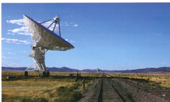
1 Eine von 27 Antennen des VLA mit Schienensystem
